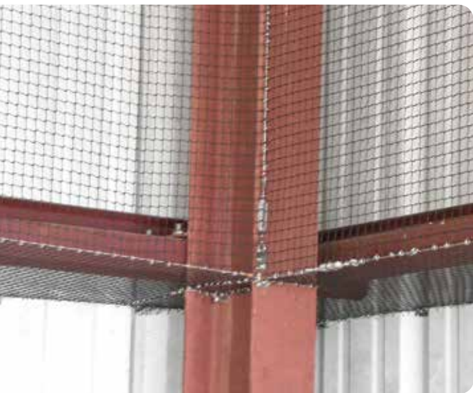
Red sin nudos en una viga interior en forma I.
